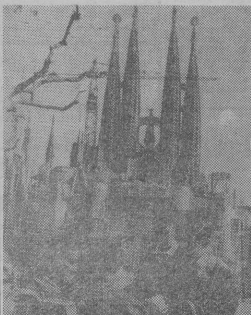
Ante las torres que el genio de Gaudí ideara para el templo de la Sagrada Familia, de Barcelona, los niños piden a los viejos para continuar las obras. Varias generaciones les separan, las empeñadas en terminar la iglesia.
