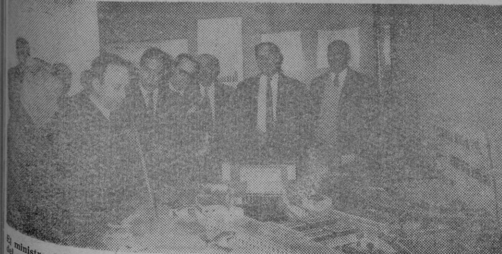
El ministro de Comunicaciones de Portugal, Gomes da Silva Ribeiro, visitó las nuevas instalaciones nacionales de Barajas. Le acompañaron en el recorrido por los nuevos edificios para los vuelos internacionales el Jefe del mismo y los miembros de su séquito, así como representantes de la Embajada de Portugal en España. En la fotografía, el señor Gomes da Silva ante la maqueta del aeropuerto.
