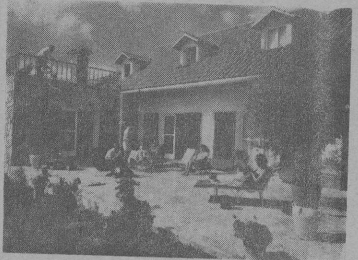
URBANIZACION CALA MURADA CUENTA CON MAS DE 200 CASAS TERMINADAS, ADEMAS DE MUCHAS EN CONSTRUCCION
