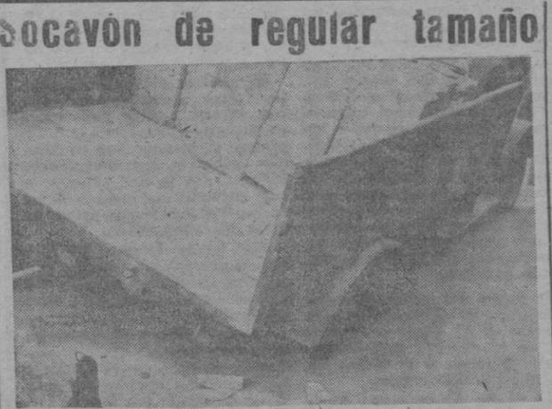
Ayer tarde y al paso de un camión de gran tonelaje, semicargado de piezas de marés de notable grosor, se hundió parte de la calzada de la plaza de Santa Magdalena. En el socavón quedó aprisionada la doble rueda posterior derecha del vehículo, hundándose hasta la ballesta como se puede apreciar en la fotografía.
