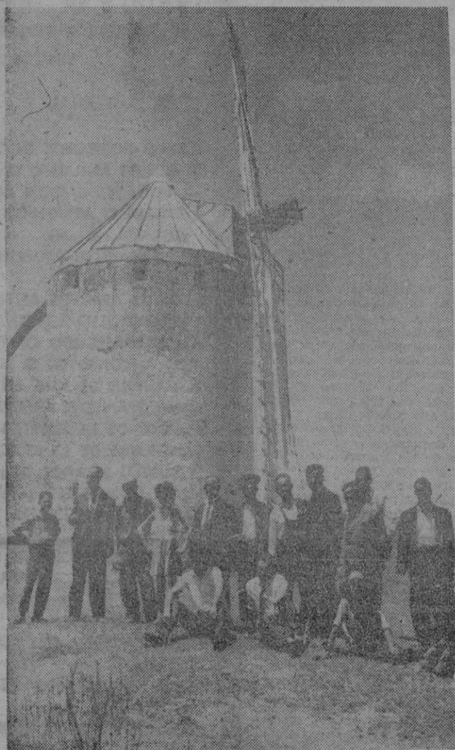
CAMUNAS (Toledo). — Este bicentenario molino de viento se llama «La Unión» y se le considera el más heroico de España y quizás de Europa, ya que sigue moliendo grano con la mitad de sus aspas. Su modesto propietario no ha podido reparar la avería que le causó un fuerte vendaval que destruyó la mitad de su velamen. Pero todavía, cuando el viento sopla aprisa, es capaz de moler cincuenta fanegas de grano en media jornada. Esta reliquia arqueológica de la molinería andante y rodante fue construida en las ruinas de otro molino erigido en la Mancha toledana en los primeros tiempos de la implantación de este sistema harinero, hace unos 400 años. — (Foto Cifra.)
