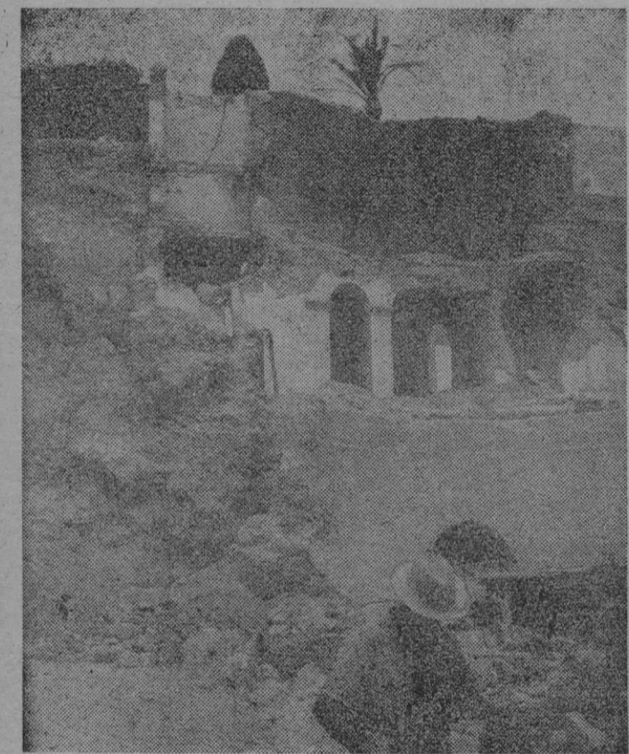
Aspecto en que quedaron las obras que se realizaban, después del desprendimiento de tierras.
