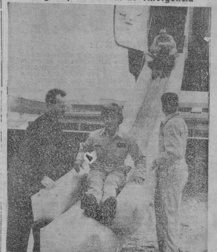
El tobogán de lona inflable, a cuya operación asistimos en esta fotografía, no está ideado para recreo, como a primera vista pudiera parecer. Se trata de un sistema de salida de emergencia para cuando un avión tiene aterrizaje forzoso. Ha sido ensayado en Copenhague por la Empresa aérea SAS.
