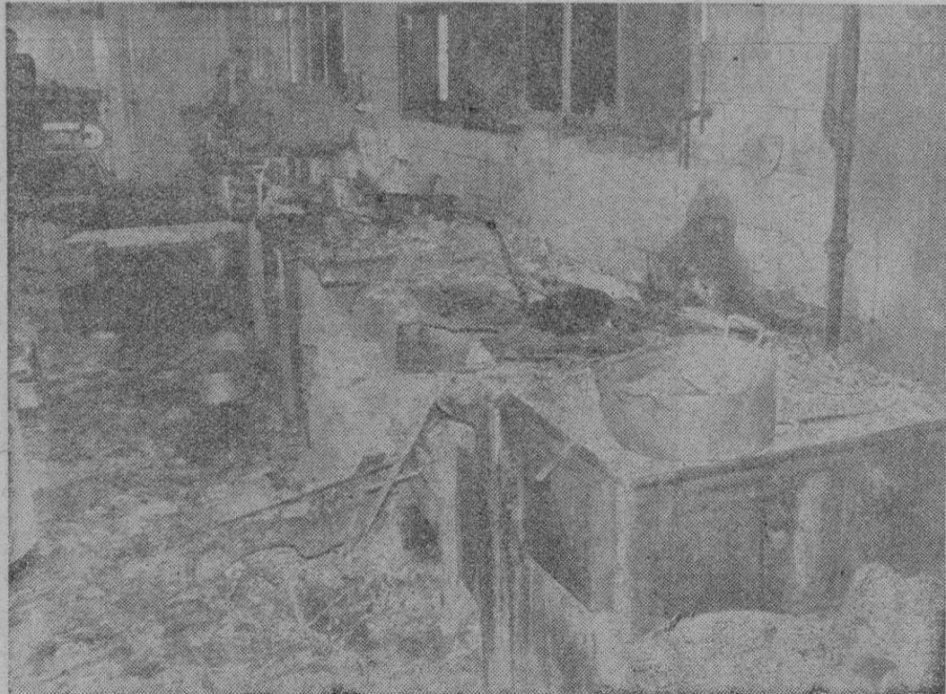
Al explotar la caldera de la cocina despidió grandes cantidades de material, derramando agua hirviendo y derribando la campana de la chimenea.
