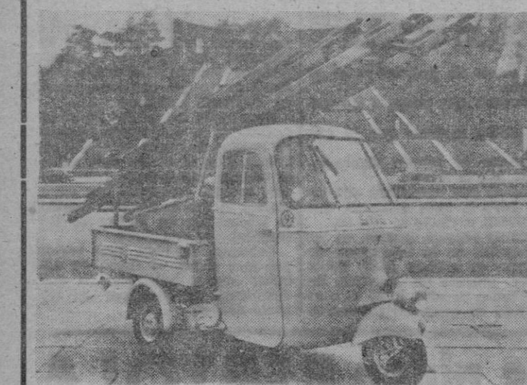
Una importante compañía de electricidad, tiene una flota de «Vespacars» que llevan, además de los dos operarios, el material y las escaleras.
