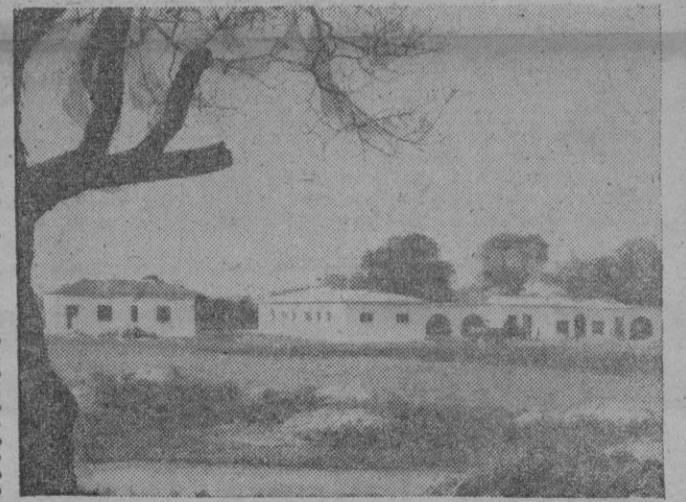
Nuevo Campo de Prácticas, con sus instalaciones en período avanzado de construcción.
