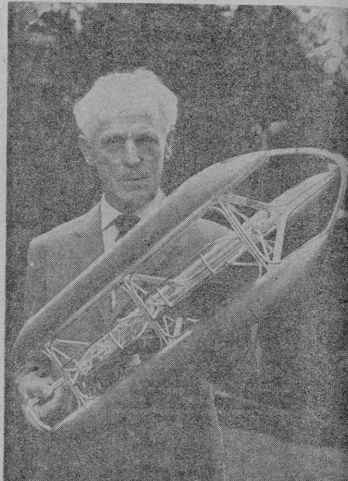
Un ingeniero de Munich, Julius Reger, acaba de construir una canoa de salvamento insumergible. La cabina del esquife está colocada entre tres flotadores, es móvil y puede flotar, incluso en caso de avería de los flotadores. El inventor decidió construir el artilugio como consecuencia de haber naufragado en el mar.
