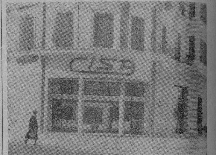
El moderno edificio que ocupa «C. I. S. A.»
