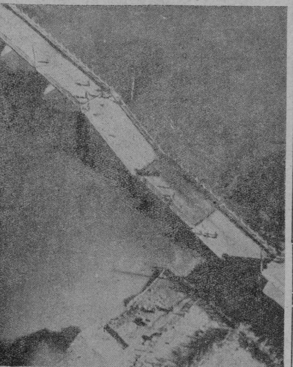
El puente sobre el río Bio Bio, el más largo de Chile con cerca de dos kilómetros de longitud, acusó el duro impacto de los sismos de grado nueve de la escala Richter. En la foto puede observarse como quedó después del primer terremoto. En sucesivos temblores se hundieron otros dos tramos. Con ello, las poblaciones industriales y mineras de Huachipato, Lota y Schöager quedaron aisladas por tierra de la capital regional Concepción. — (Foto EUROPA PRESS).
