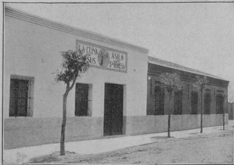
Fachada de la Cuna de Jesús del Puente de Segovia.
