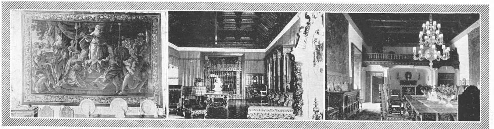
1. Un tapiz de los que adornan el comedor.—2. El salón principal que comunica con el comedor. Al fondo una reja policromada, de gran valor, procedente de una iglesia derruida en Andalucía.—3. El antiguo refectorio convertido en comedor. Magnífico artesonado. Al fondo la tribuna en la cual se leían, durante las comidas libros sagrados.
