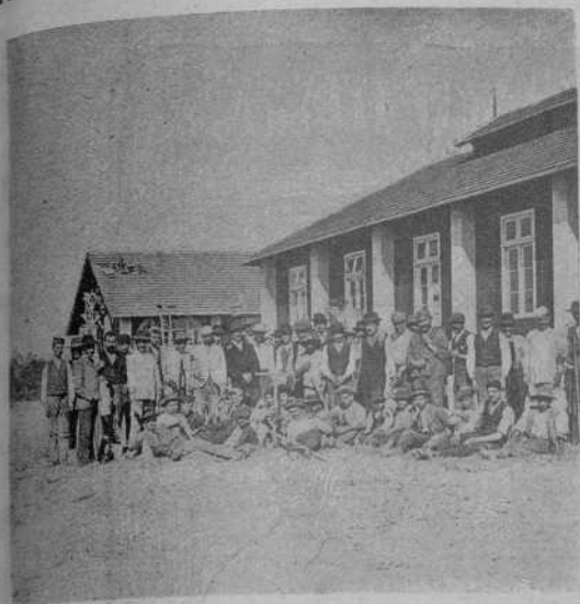
Obrers ocupats en la construcció del Hospital d'apestats.
