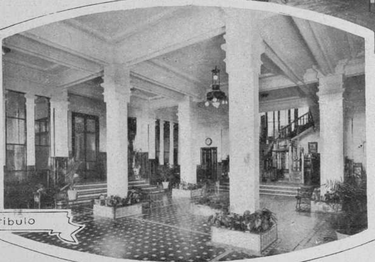
Vista parcial del hall
