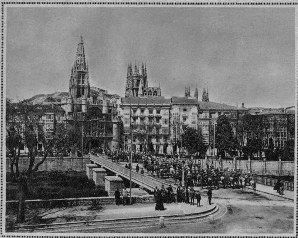
Burgos.—El puente y el Arco de Santa María, y detrás, las torres de la Catedral (Fot. Vadillo)
