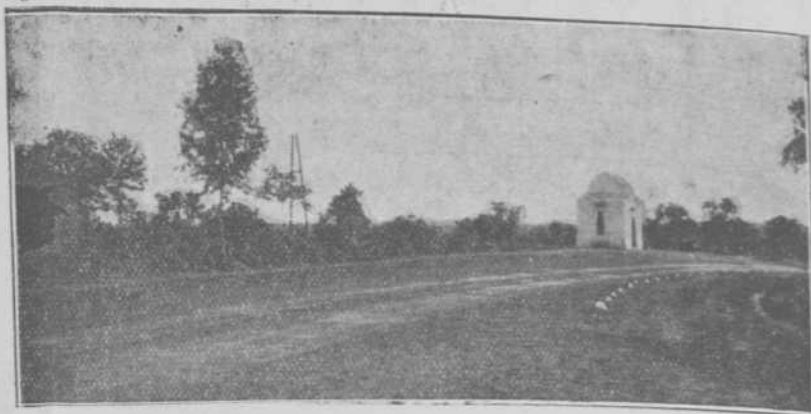
Como perdidas en las gabas, estas casetas son constantes vigías...
