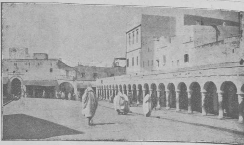
Aspecto del Zoco de Dentro, donde la pavimentación, realizada por la Junta, no perjudica al conjunto estético de la construcción.
