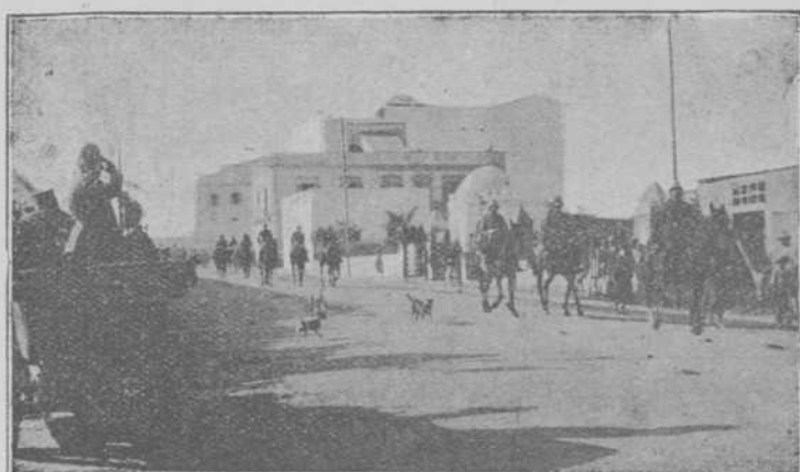
La Avenida Reina Victoria en 1914, cuando se denominaba Carretera de Alcázar.
