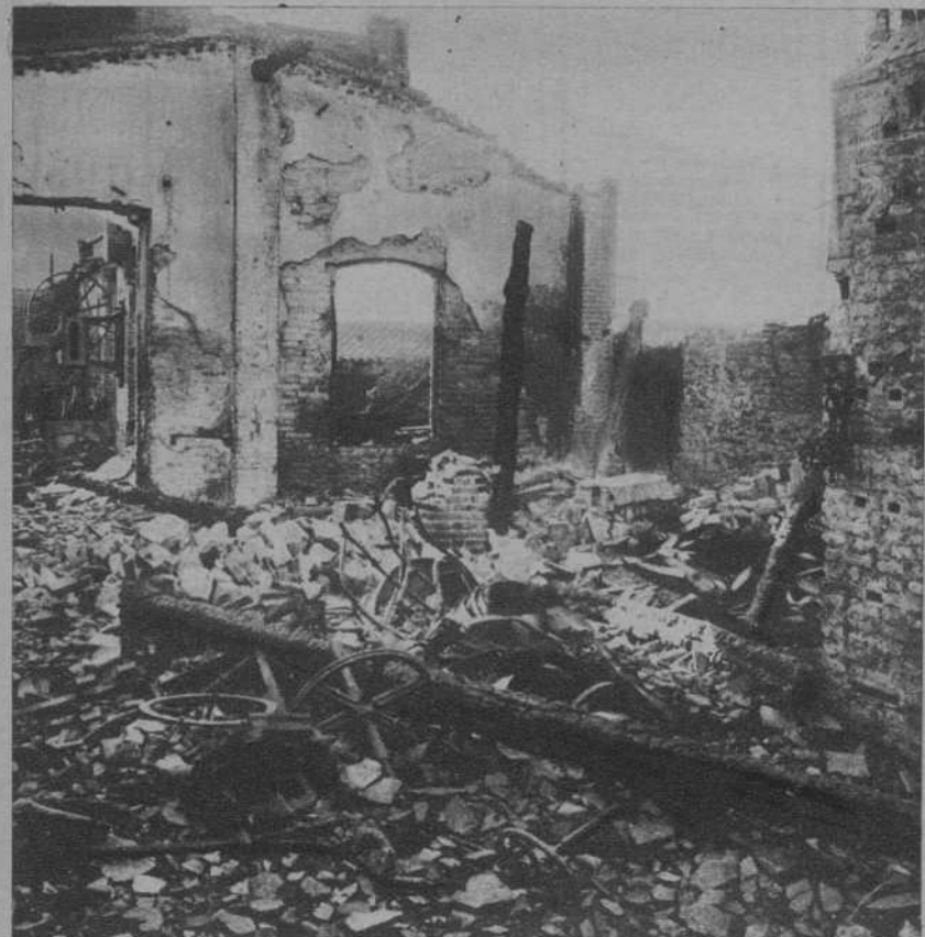
Reus. — Taller de serrería mecánica de la calle de Próspero Bofarull, destruido por un incendio. — (Fot. Vallvé)
