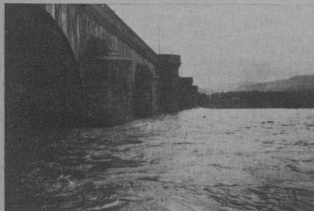
Molins de Rey. — Puente sobre el Llobregat Autor: Delfín Mestres, de Molins de Rey
