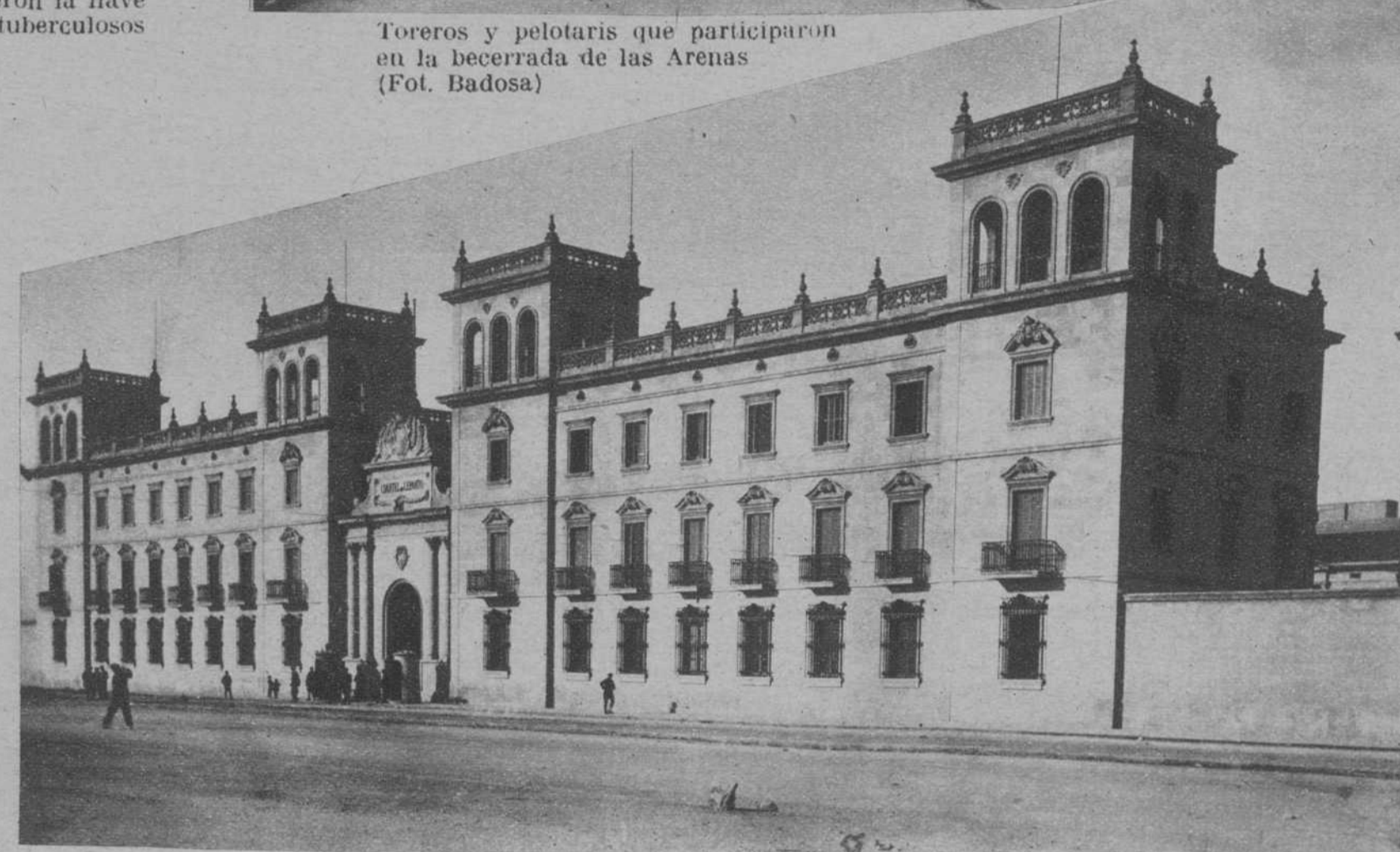
Cuartel de Lepanto, destinado al 4.º batallón de Ingenieros Zapadores-Minadores
