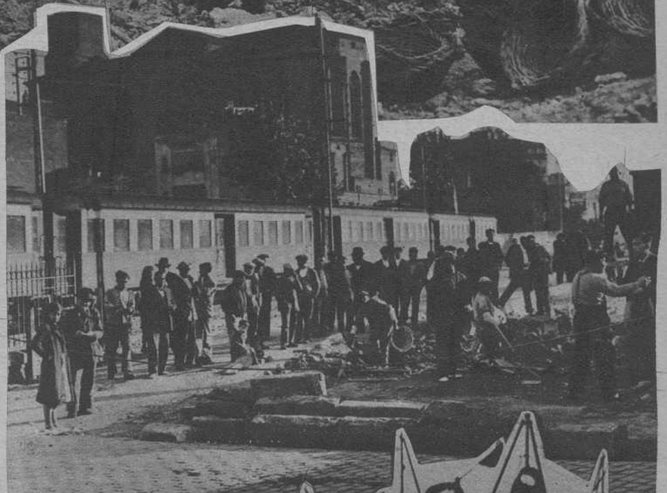
El comienzo de las obras en el paso a nivel de la Gran Via Meridiana.-(Fts. Badosa)
