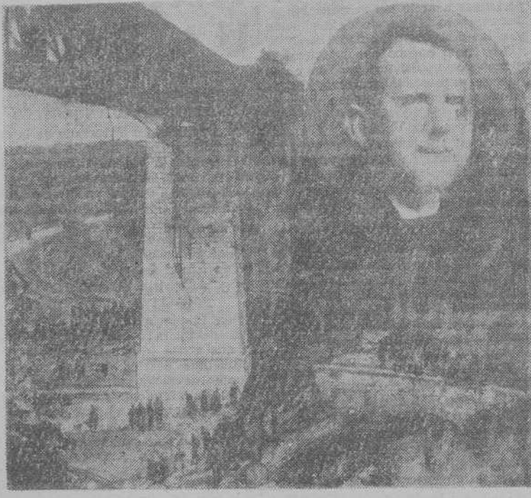
EL PUENTE VOLADO POR SILVESTRE MATSUKA (EN EL OVALO) AL PASO DEL EXPRESO BUDAPEST-VIENA RESULTANDO 22 MUERTOS
