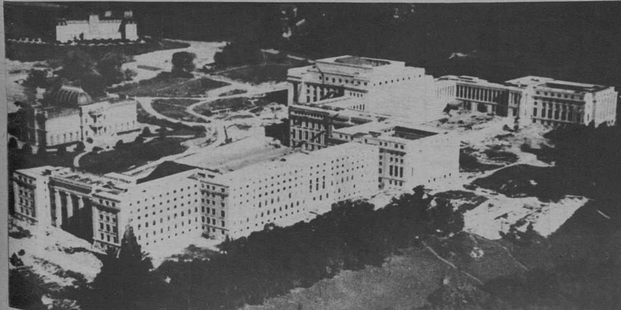
Ginebra.—El nuevo palacio de la Sociedad de Naciones, que en sus dimensiones externas es sin duda uno de los mayores edificios del mundo, ha sido terminado en su parte exterior, habiendo dado comienzo a las instalaciones del interior. La fotografía representa una vista de conjunto del palacio, tomada desde un avión. (Fot. Vidal)
