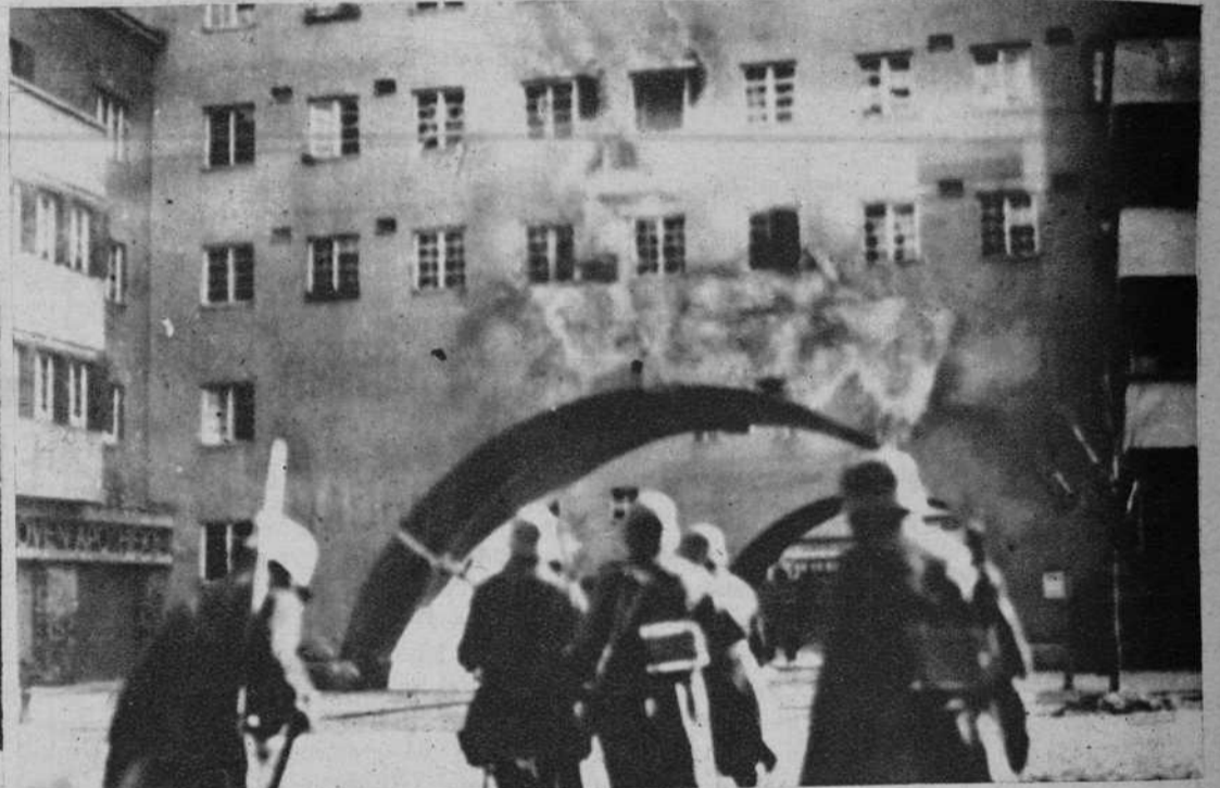
La Casa Harl Marse, el gran inmueble obrero de Viena, después de ser bombardeado para vencer la resistencia de los socialistas, fué ocupada por las tropas, pudiendo observarse en la fotografía los destrozos causados por los obuses.
