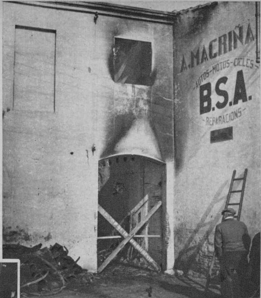
Premiá de Mar.—La entrada a la ferretería incendiada.—(Fot. P. Rozas)
