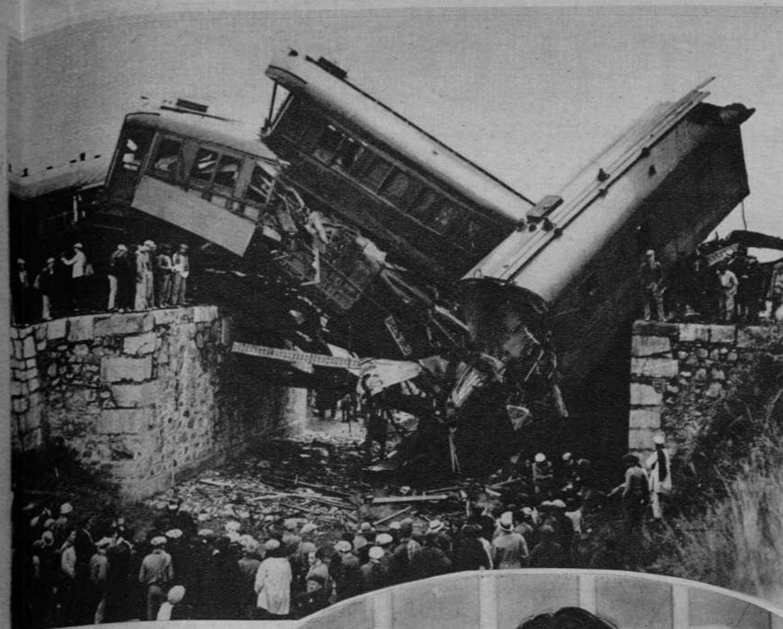
Estado en que quedaron los vagones del rápido
