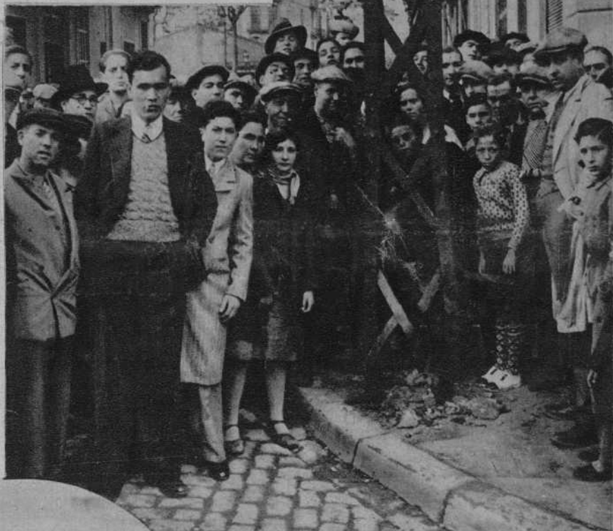
Poste derrumbado por una bomba en la calle Montaña, de la barriada del Clot, que ocasionó dos muertos y varios heridos. - (Ft. Merletti)
