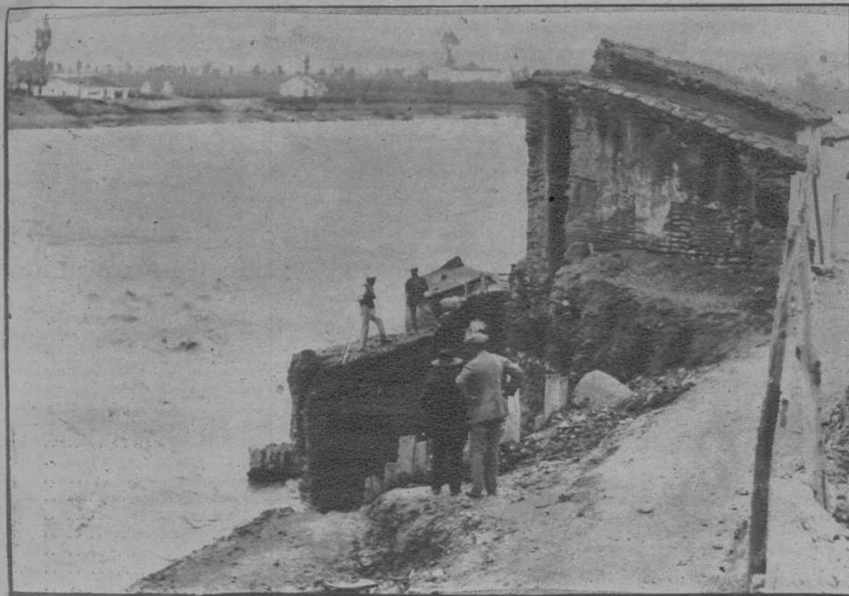
LOS ÚLTIMOS TEMPORALES. ALCALA DEL RIO (SEVILLA).—Casas próximas al río Guaraquirivir, que fueron derrumbadas por la corriente (Fot. Sánchez del Pando)
