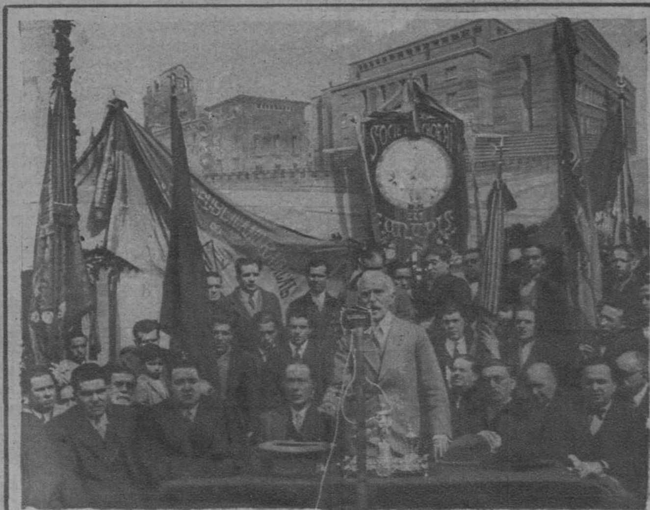
El Presidente de la Generalidad, don Francisco Maciá, en un momento del discurso que pronunció en el acto inaugural de las obras de construcción del Grupo Escolar «Collaso y Gil». — (Fot. Merletti)
