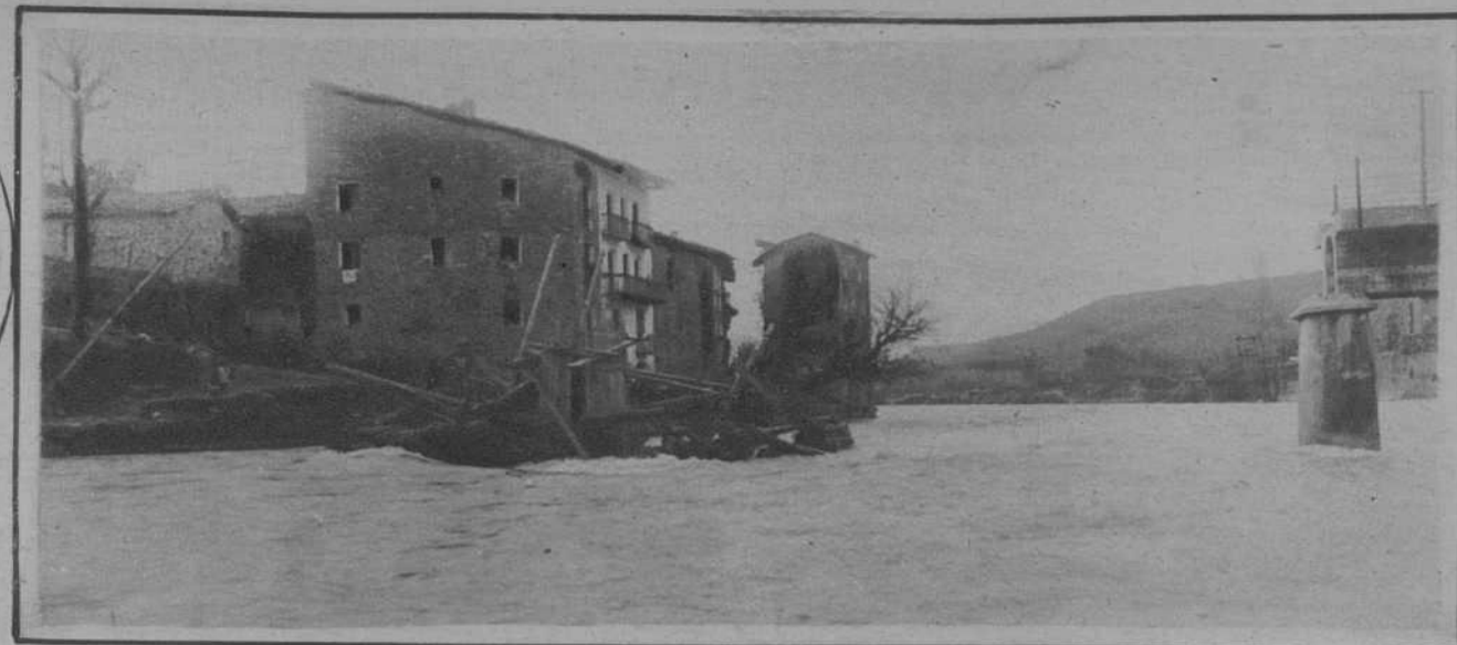
Pobla de Segur (Lérida).—Un aspecto del río Noguera Pallaresa, donde se construye el nuevo puente, en uno de cuyos lados había una pasarela que ha sido arrancada por la crecida de dicho río. — (Fot. Gordó)
