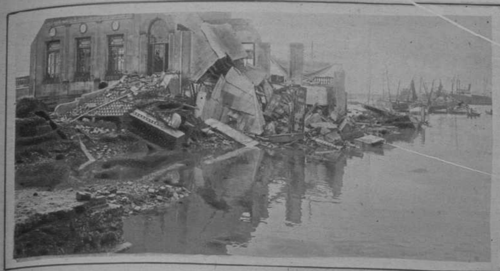
El edificio del Club Náutico, derrumbado por la fuerza de las aguas
