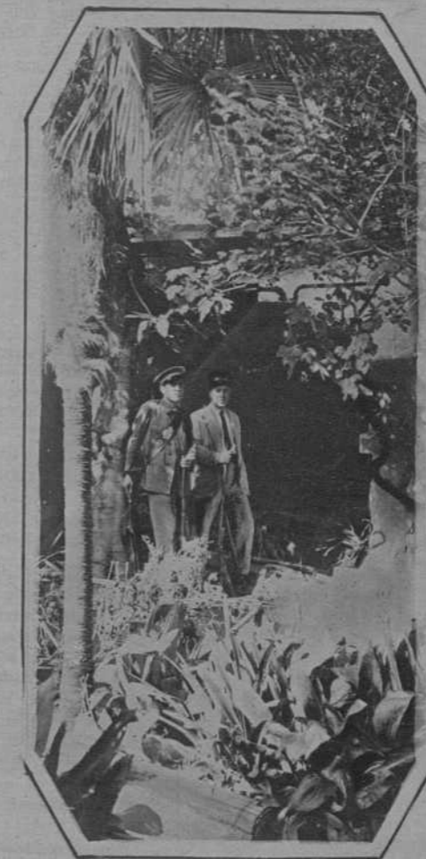
Boquete por donde se abrieron paso las aguas que inundaron la viviedna donde dormía el matrimonio Guiré-Recasens, cuyo nivel de agua alcanzó dos metros y medio
