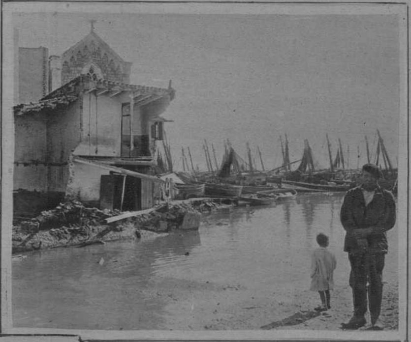
Pavimento y edificio de la Plaza de San Pedro, del barrio de pescadores del Serrallo, arrastrado por la corriente (Fots. Vallvé)
