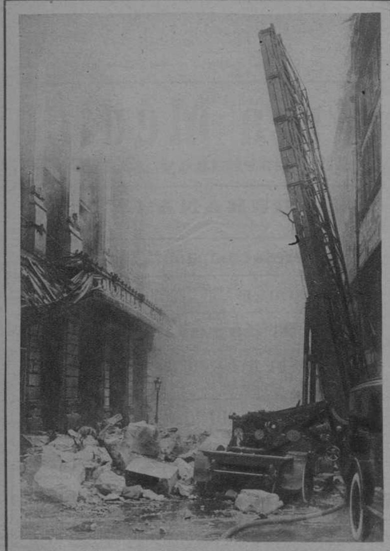
En París, un formidable incendio ha destruido los grandiosos almacenes «Nouvelles Galeries». El fuego dejó sólo en pie las cuatro paredes. De la magnitud del siniestro da idea la presente fotografía. — (Fl. S. G. P.)
