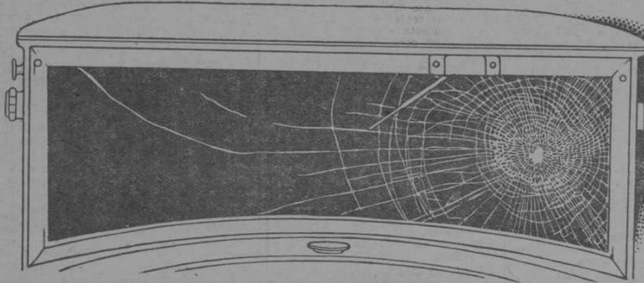
Este detalle muestra el estado en que quedó un parabrisas después de un accidente que, de no haber sido el Cristal de Seguridad, hubiese revestido la mayor gravedad
