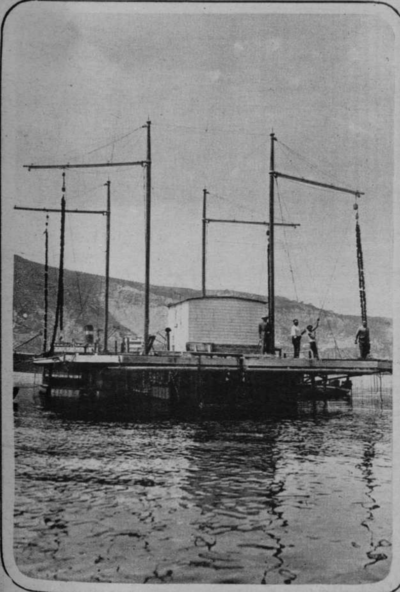
Sobre seis flotadores de madera se levanta el armazón de viguetas de hierro, travesaños de madera, mástiles, cuerdas, poleas y la caseta, que es el Puesto
