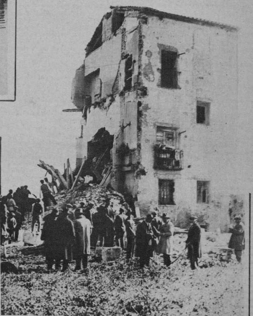
En Valencia ha ocurrido una catástrofe que ha llenado de luto la población. Un edificio se derrumbó, ocasionando la desgracia tres víctimas. Muestran nuestras fotografías, el viejo edificio siniestrado y el momento en que los bomberos extraían los cadáveres de entre los escombros. — (Fots. Vidal)
