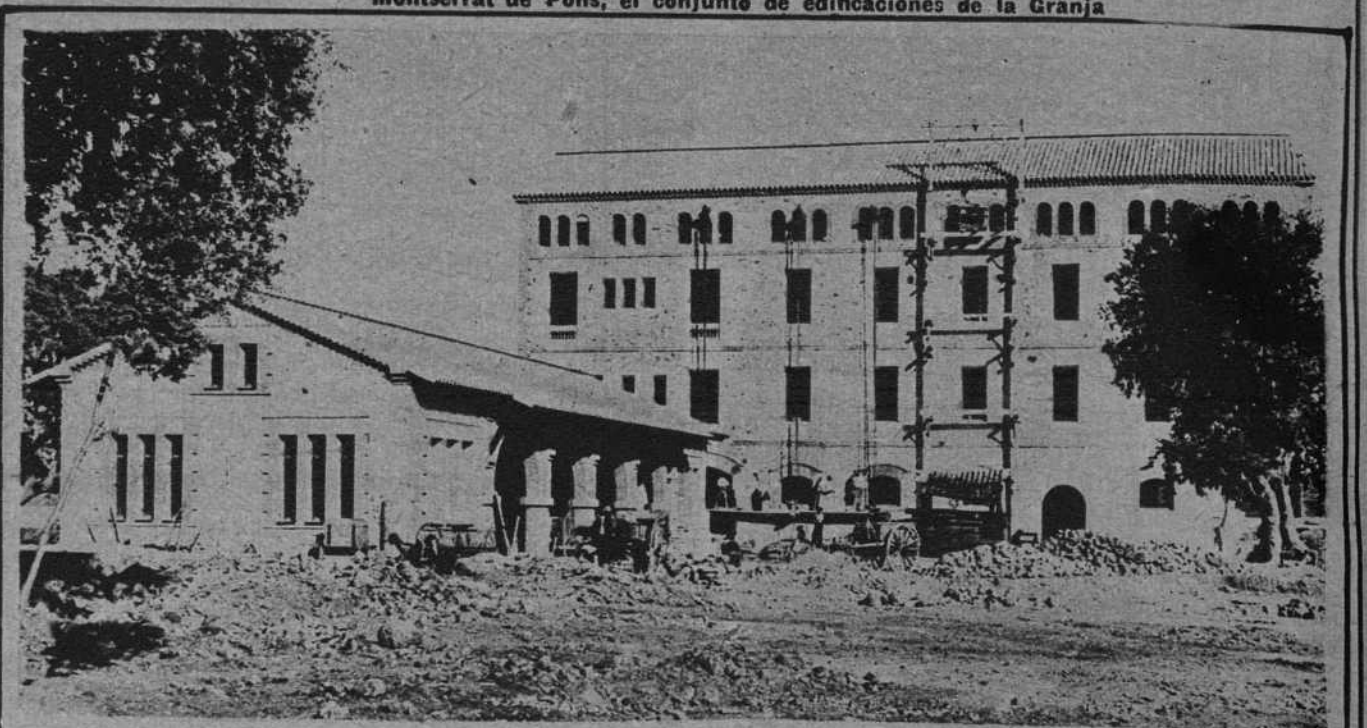
Hangar de máquinas y albergue de asilados (Fots. Maymó)
