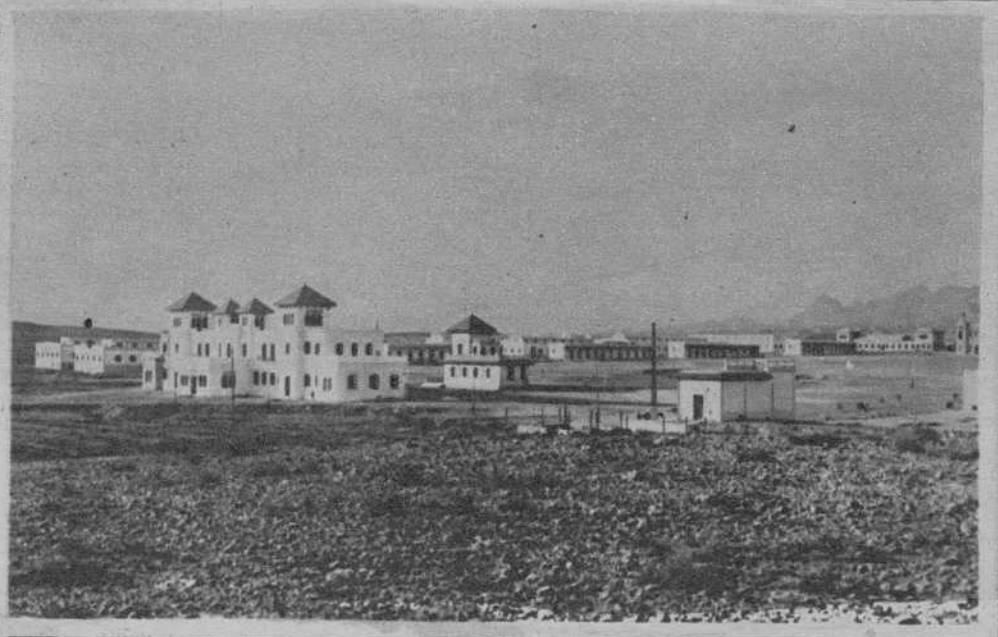
ALMERIA.—Apertura de la carretera militar que une el Campamento de Soto Mayor con la capital.—La inauguración de la carretera.—El Campamento.—(Fots. Fernández)
