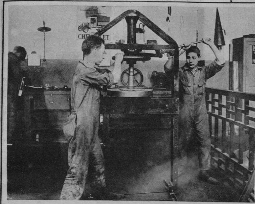
Prensa para la extracción de piezas embutidas a presión
