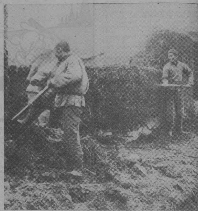
Construcción de chozas de barro a lo largo del ferrocarril de Taonan a Sólun
