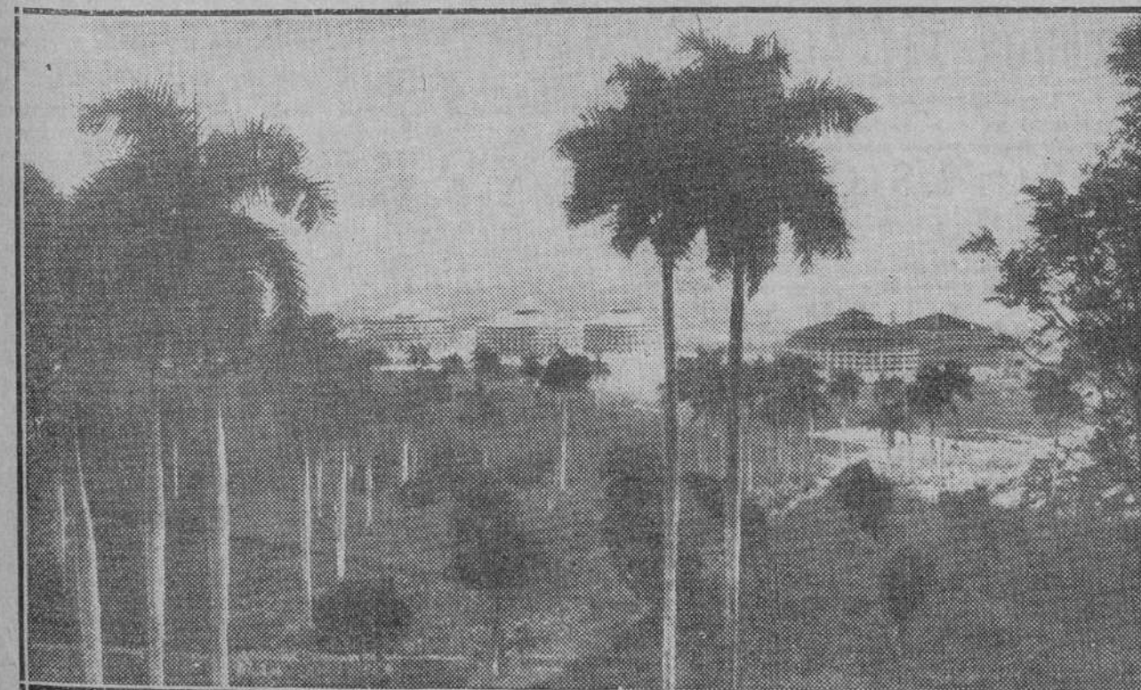
La penitenciaría de Cuba, la mejor del mundo, quizás, construída durante el régimen de Machado
