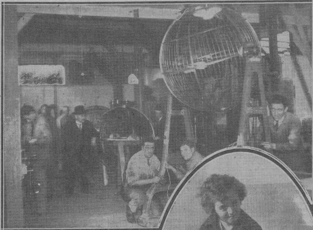
Terminando la instalación eléctrica que ha de mover los bombos
