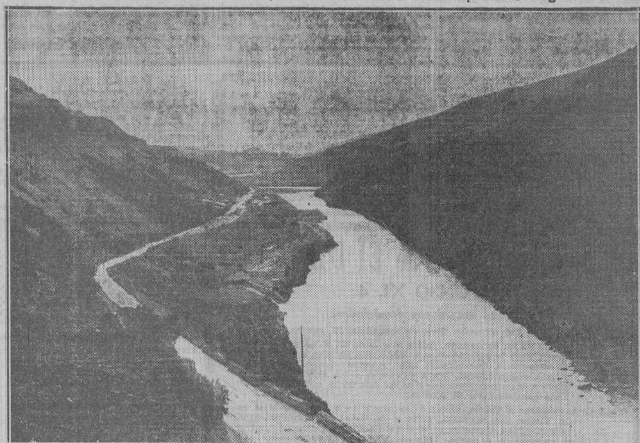
Estrechamiento del río Aragón, donde se está construyendo el pantano de Yesa, que ha de alimentar el canal de las Bárdenas
