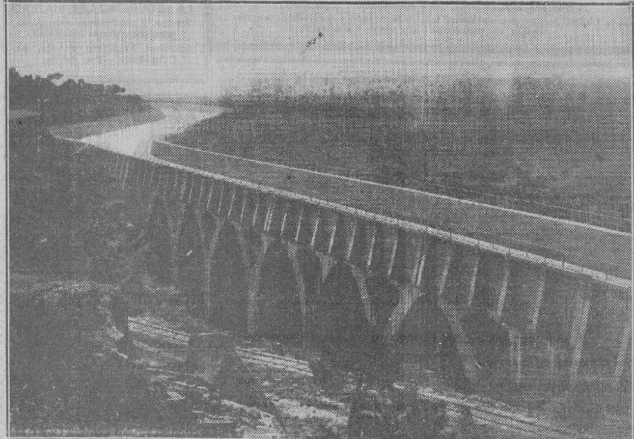
Acueducto en el canal del Gállego, que une la presa de Biscarrués con el pantano de Sotonera, del que arranca el canal de los Monegros
