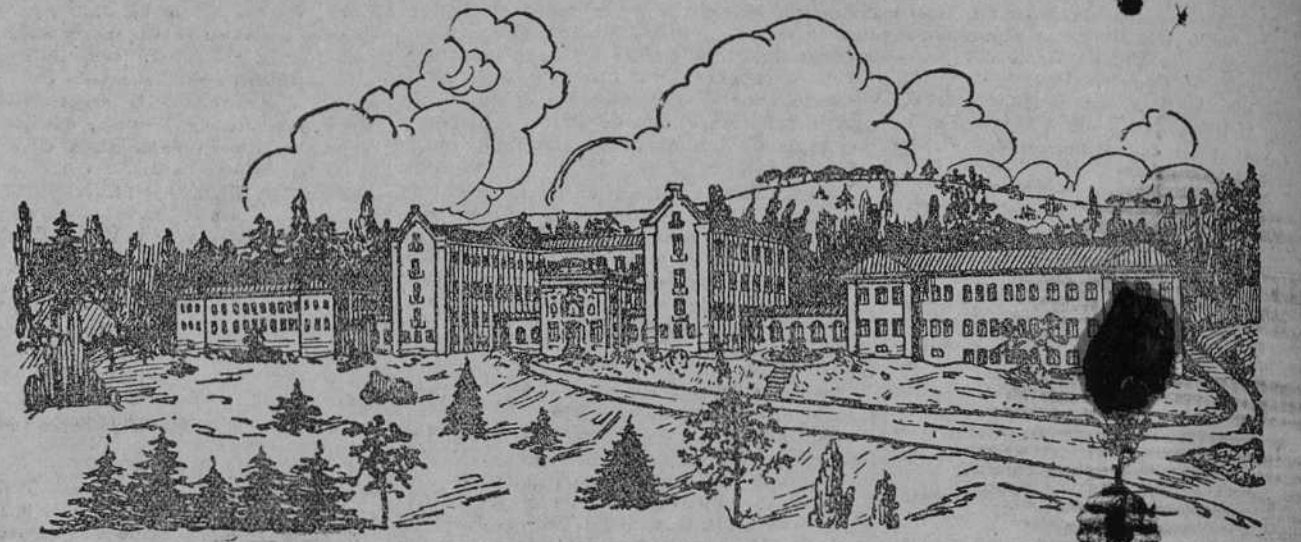
VISTA GENERAL DEL EDIFICIO
