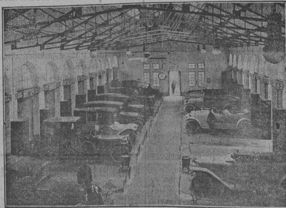
COCHERA-GARAGE DEL CENTRO ELECTROTÉCNICO Y DE COMUNICACIONES
