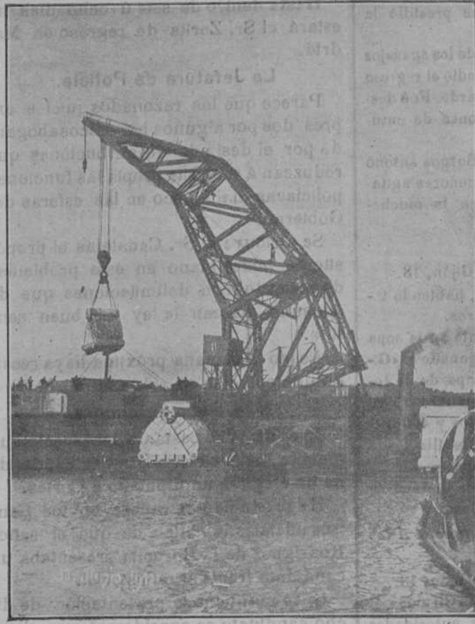
Grúa flotante elevando calderas á bordo del «España», con peso de 22 toneladas.
