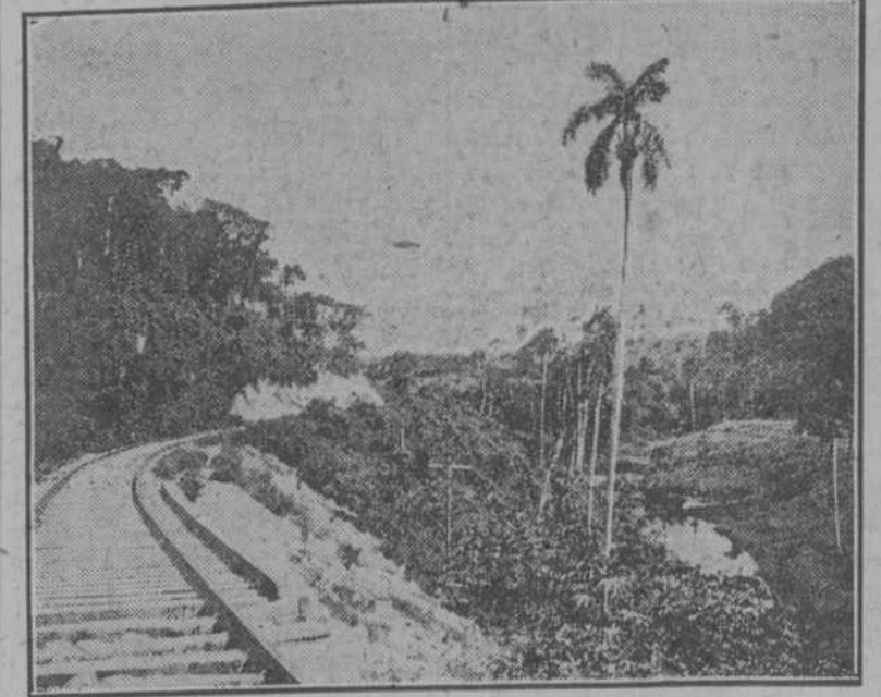
PAISAJE EN LA VIA EN CONSTRUCCION, EN LOS VALLES DEL RIO CHAMBAS
