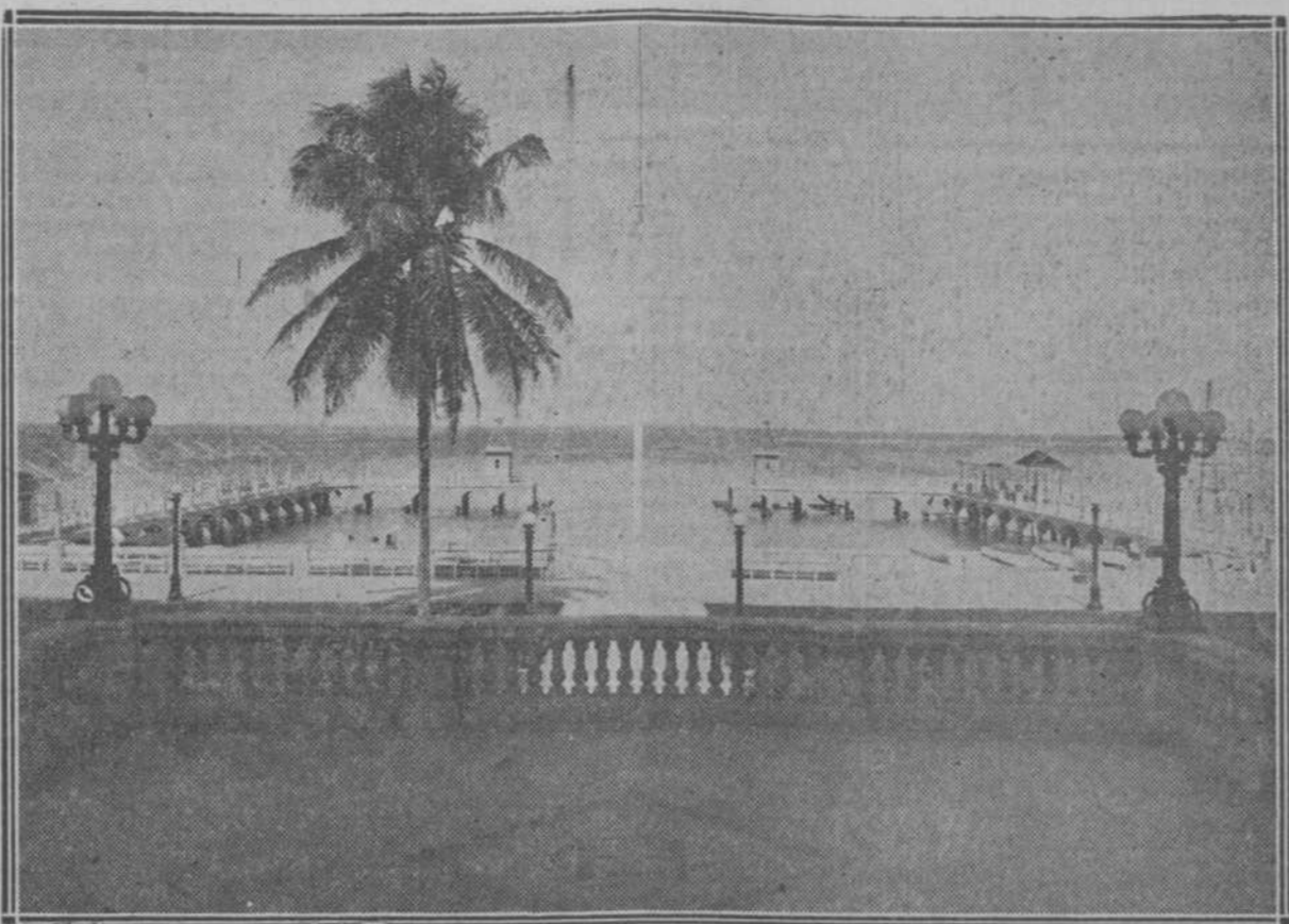
Vista del nuevo palacio del Habana Yacht Club por su frente a la playa y a la que dan acceso las dos escaleras que se extienden por ambos costados. Como se puede notar, desde este hermoso barandaje del club se dominan el mar azul y la playa de blanquinosas arenas, la pequeña bahía artificial destinada para baño y esparcimiento de los socios y sus familias. (Foto Buendía)
