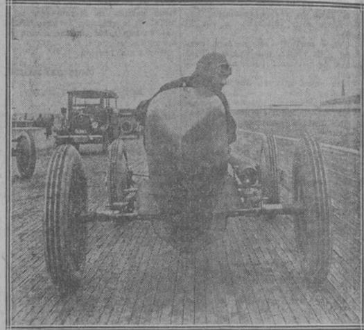
El DURANT visto por detrás muestra lo afilado de la carrocería para evitar el vacío y los remolinos de aire detrás del coche. Obsérvese que el conductor, que en este caso es Mr. R. C. Durant, puede ver perfectamente las cuatro gomas del coche, cosa necesaria a falta de ayudante. Los frenos en las ruedas traseras han desaparecido.
