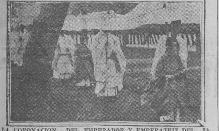
LA CORONACION DEL EMPERADOR Y EMPERATRIZ DEL JAPON.—Esta fotografía muestra en la parte superior, una de las procesiones de Tablones dirigiéndose a Kyoto. Los edificios donde se han de celebrar los banquetes, estas, etc., son construidos con maderas escogidas por el Emperador, y después llevadas a Kyoto en procesiones; tal y como aparece en el grabado. En la parte inferior se ve a los sacerdotes de Shinto, arreglando el asiento escudo en memoria del último Mikado, que falleció el día 30 de Julio de 1912. Las "virgenes sagradas" que bailarán durante las ceremonias de la coronación, se ven en la fotografía acompañadas de los sacerdotes de Shinto, quienes han estado ensayándolas para las ceremonias.
