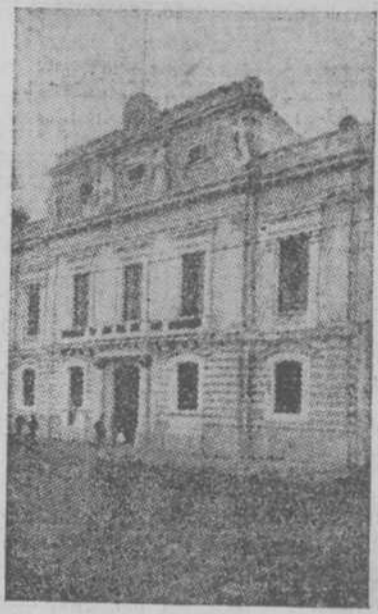
El edificio del Ministerio de Relaciones Exteriores.
