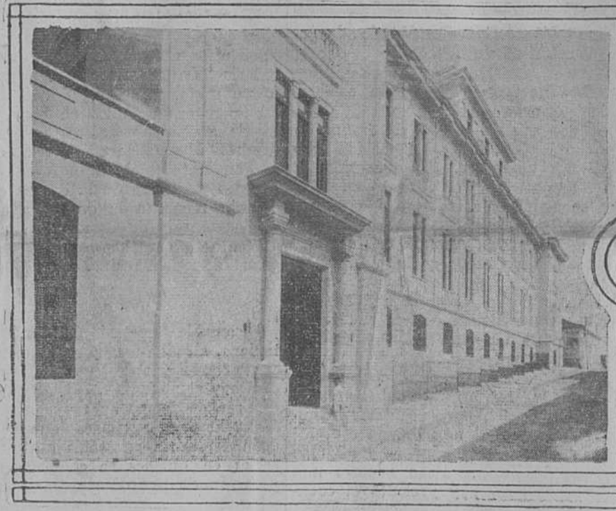
Vista exterior del Colegio
