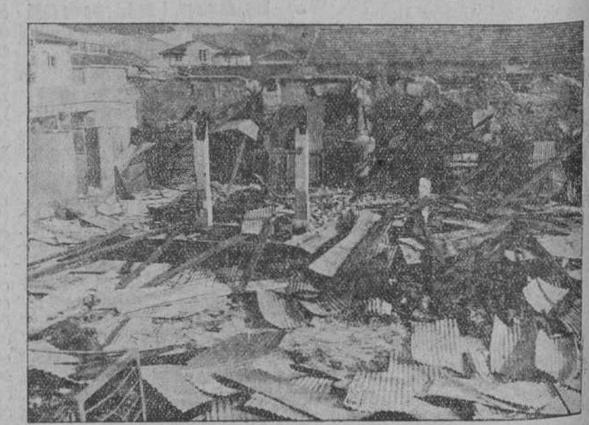
Una de las dependencias destruidas por el fuego. (Foto Samot.)
