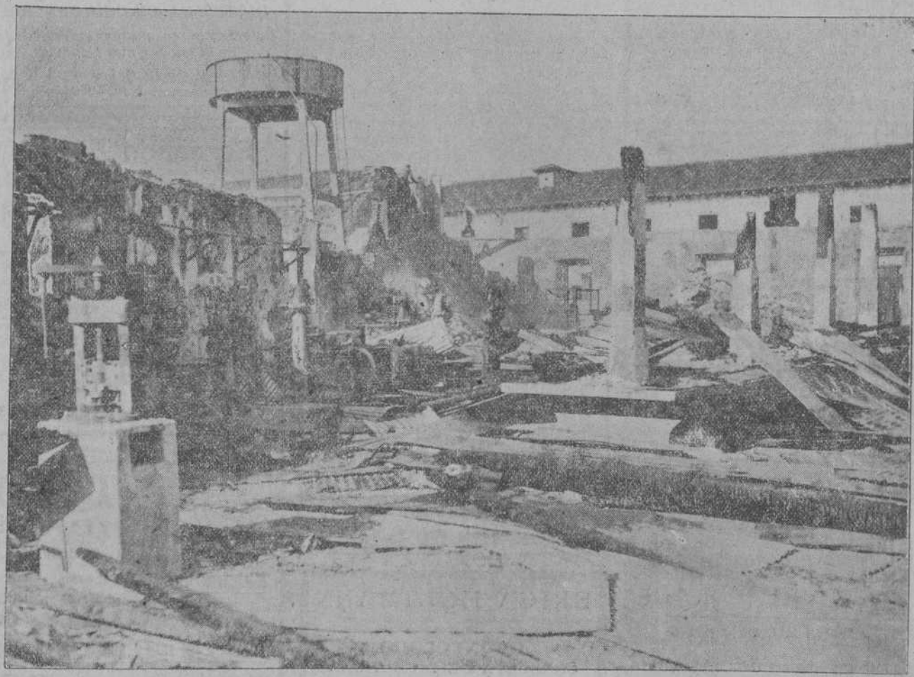
DEL INCENDIO DE SANTAÑA.—La sala de máquinas de la fábrica de Hijos de C. Albo, que quedó reducida a cenizas. (Foto Famot.)
